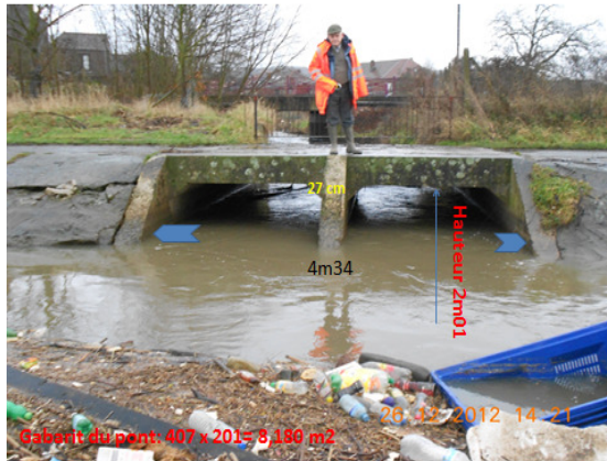
Gabarit du pont du Hain à sa sortie dans le canal
