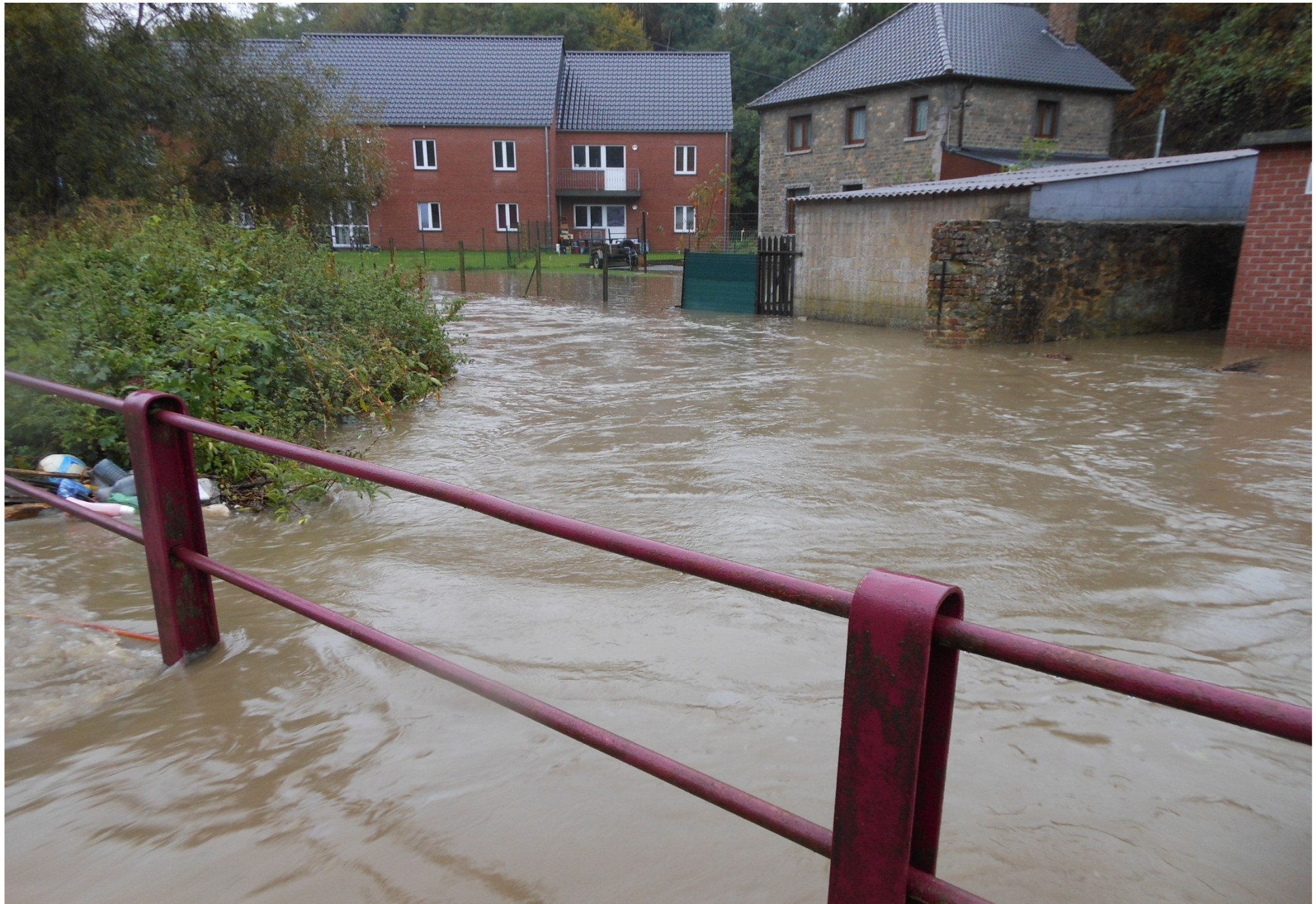
Ce pont lors des inondations de la rue des Combattants du 04/10/2012
