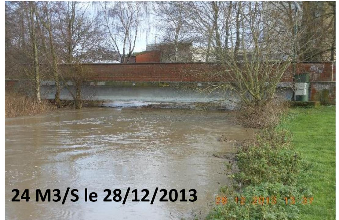
L'aménagement en 2012 par le S.P.W. du by-pass de Ripain a augmenté le débit de passage de 24M3/S à 40 M3/S. Cet aménagement a augmenté la capacité de débit et par conséquent la rapidité de la montée des eaux vers les zones habitées situées en aval.
