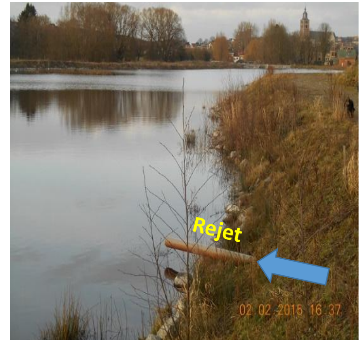
Le niveau d'eau du lac est maintenu à hauteur de la dernière planche du moine grâce à cette alimentation
