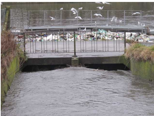
3 - « Confluence » avec canal - 11h02
