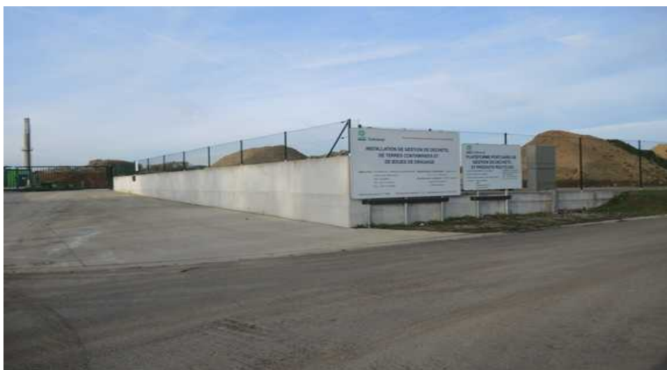
Terres polluées à proximité des habitations
