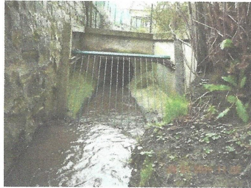
Pertuis de l'Achonfosse sous un jardin à l'arrière d'une maison de la rue du Stierbecq. Le diamètre de ce pertuis fait 75 cm.
