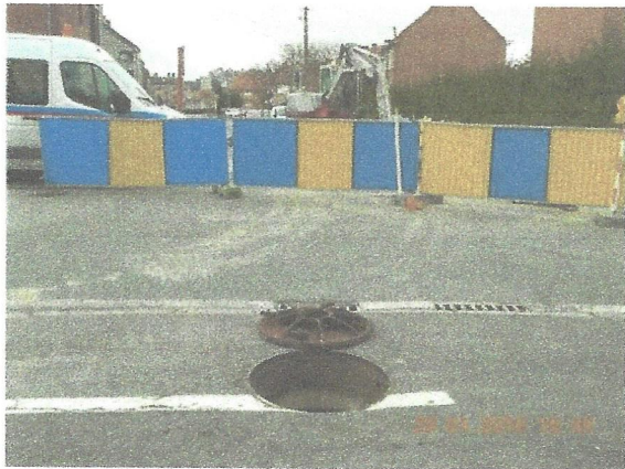
Rue du Stierbecq, taque sous laquelle coule l'Achonfosse. (En face du n°45)
