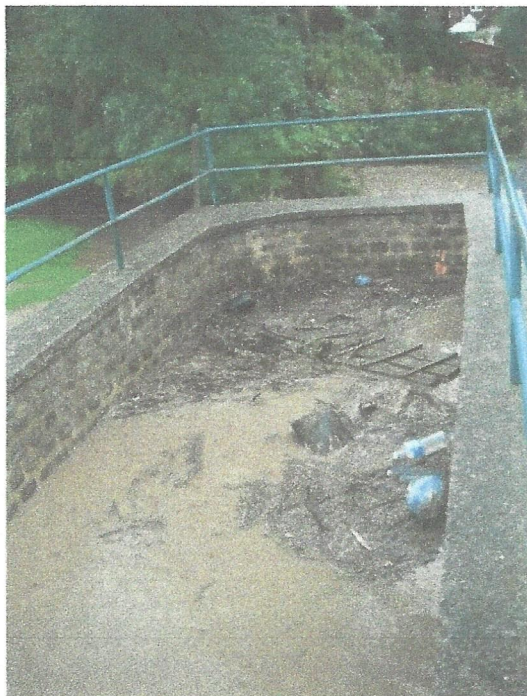
Ouvrage sur l'Achonfosse au bout de la rue de la Briqueterie. (23/08/2011)
