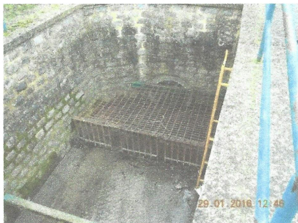
Le diamètre du tuyau de fuite de cet ouvrage est 70 cm.
