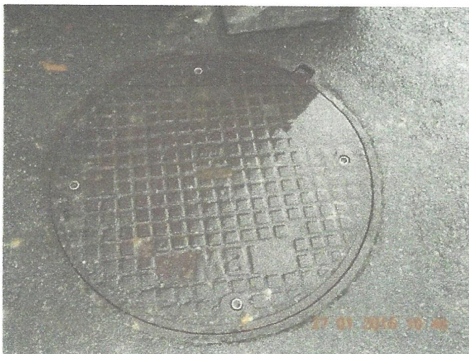
Vu la violence des débits de l'Achonfosse, les services techniques ont été contraints de boulonner cette taque. Bonne preuve qu'il y a d'énormes problèmes de pression.
