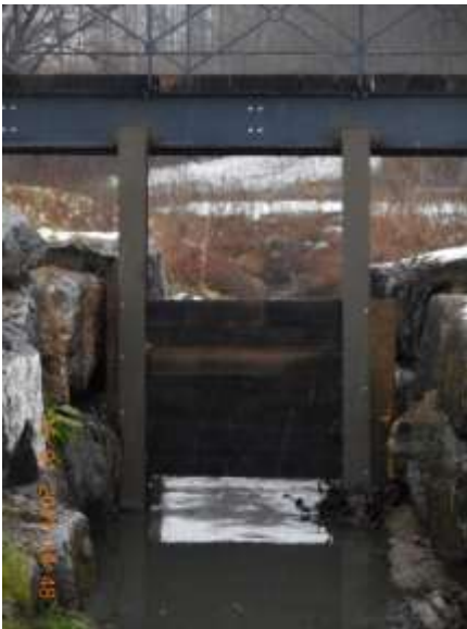
Dispositif de retenue statique et non réglable du « PARADIS »
