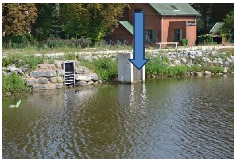
Ouvrage de sortie, l'eau passe au-dessus de la planche du moine
