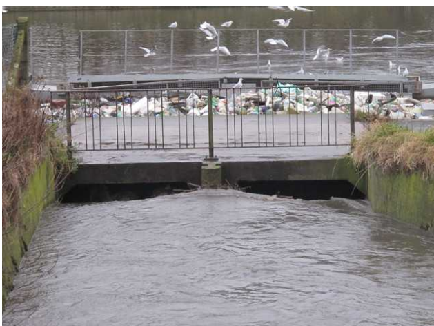
3 - « Confluence » avec canal - 11h02
