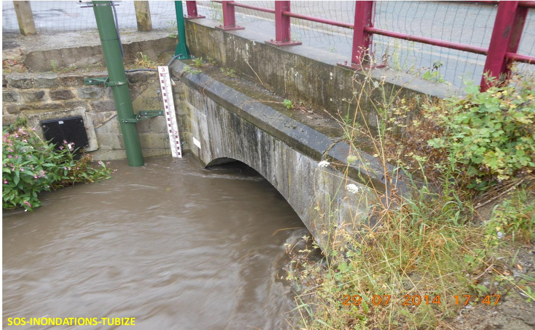
Situation du pont rue de la Potterree, à hauteur du rejet de la station d'épuration de Braine le Château à 17h52. (le limnimètre indique (aqualim) 1M90 et 13,824M3/S
