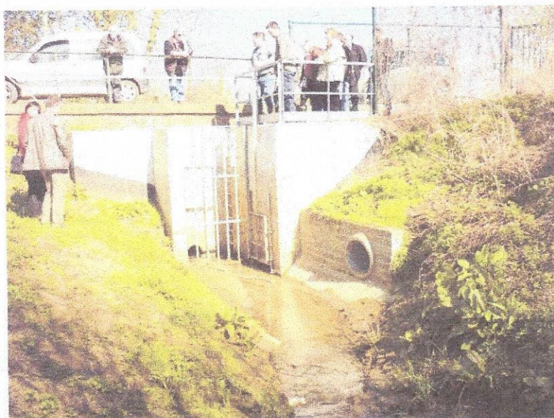
Ouvrage de régulation de débit d'un cours d'eau à Silly
