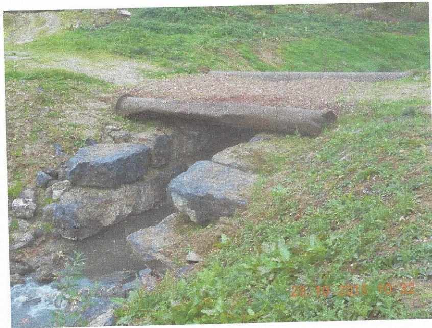
Travaux récemment réalisés, juste en aval de la zone de débordement
