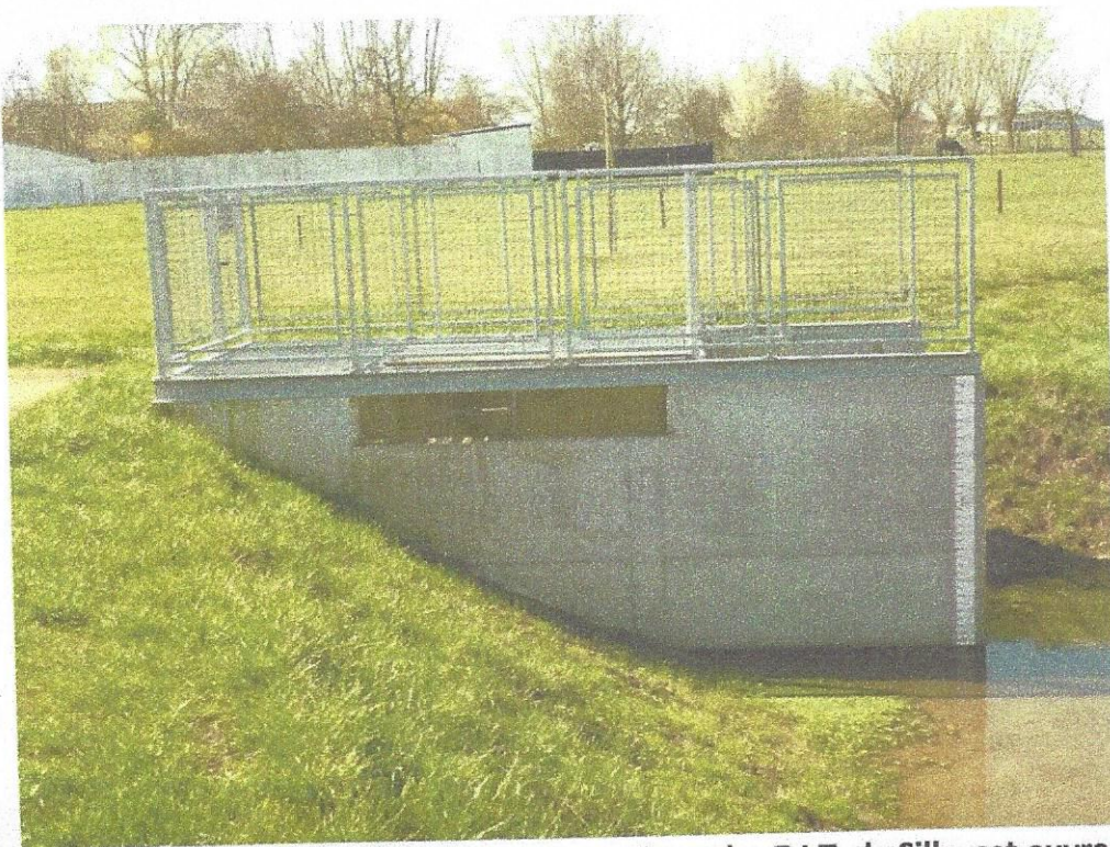
Ouvrage permettant de réguler le niveau d'une des Z.I.T. de Silly, cet ouvrage est doté d'une échelle de hauteur de niveau.
