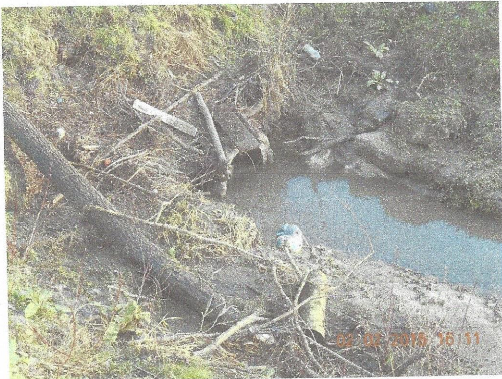
Même tuyau de fuite complètement dégagé (02/02/2015)
