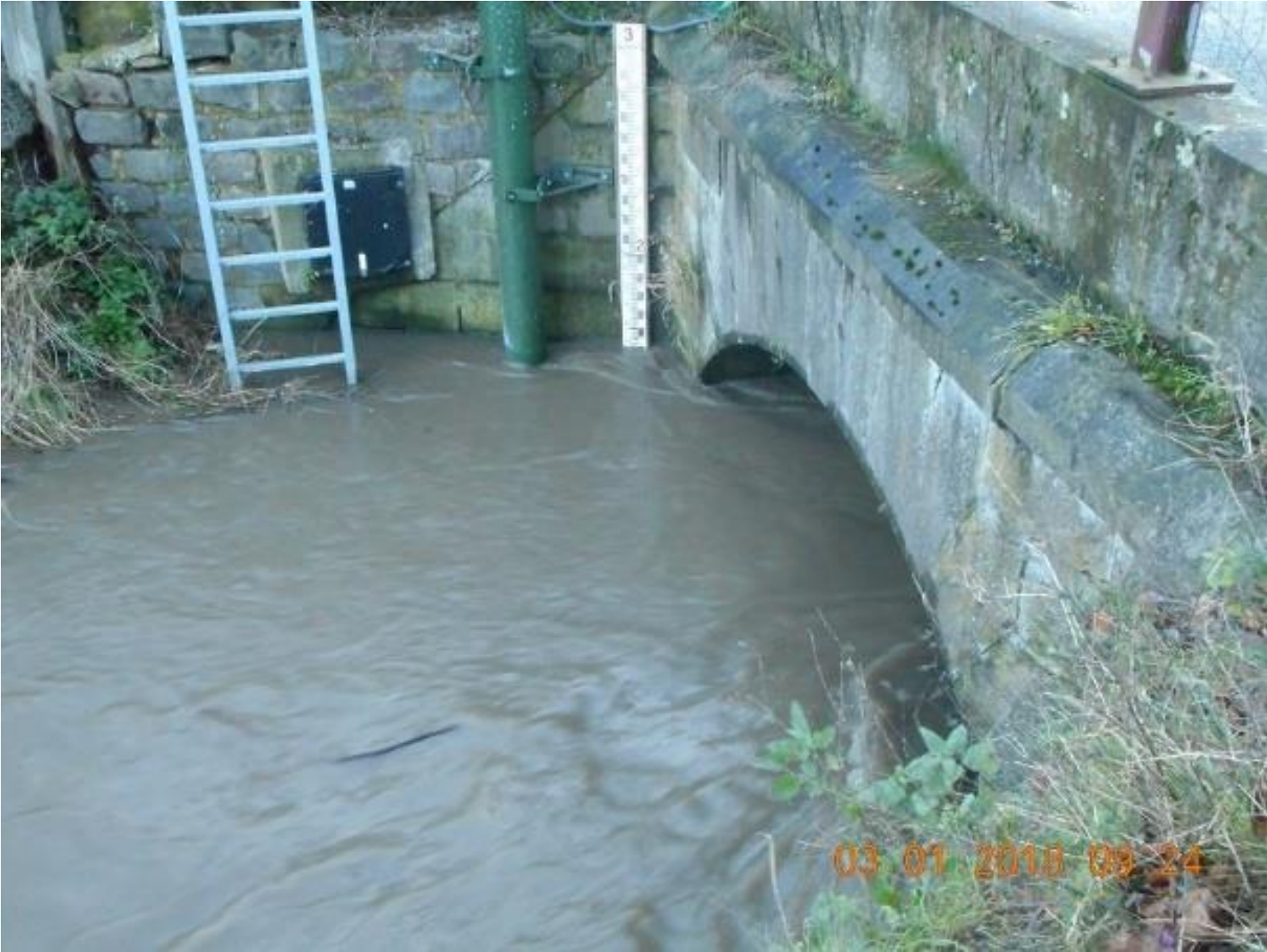
Limnimètre situé rue des combattants à Clabecq à 9h24.
