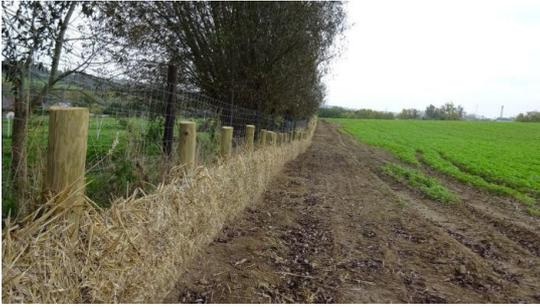
Il s'agit d'un barrage filtrant utilisé pour ralentir le flux d'eaux boueuses, sous la forme d'une barrière épaisse faite de matériel végétal (branchages, paille, copeaux), avec ou sans grillage, maintenu solidement par des piquets.
