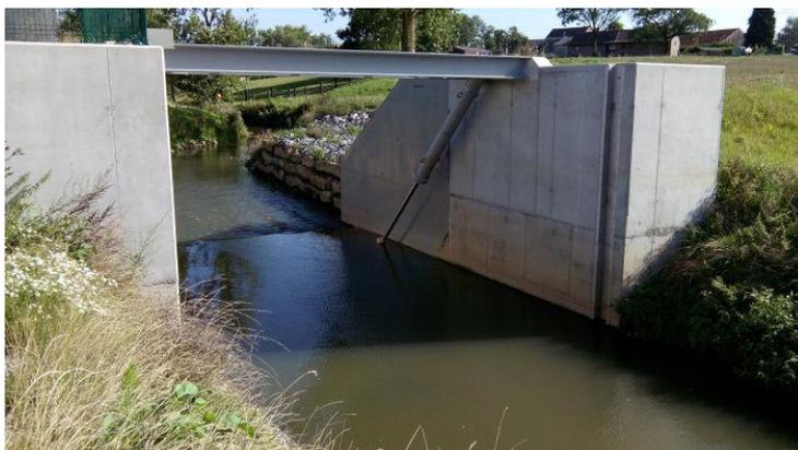
*ZIT de Steenkerque avec une vanne automatique*
