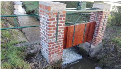
*Batardeau aux étangs de Couercq : barrage destiné à la retenue d'eau provisoire*
