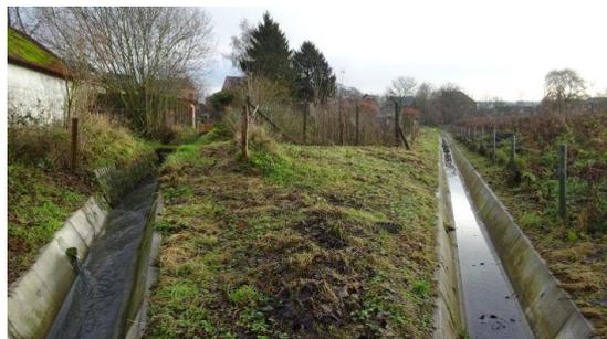
De l'anglais « by-pass », littéralement « passer au-delà », le bipasse est un dispositif artificiel qui permet d'effectuer une déviation du cours naturel de l'eau vers un second tracé afin de soulager un endroit sensible.
