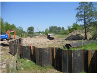
*Palplanche à la ZIT de Steenkerque : pieu profilé conçu pour être battu en terre et s'emboitant avec les pieux voisins par l'intermédiaire de nervures permettant de constituer un mur de soutènement ou un écran imperméable.*
