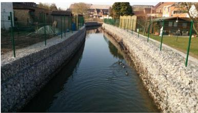
*Gabion au quartier du 45 à Clabecq : ouvrage constitué de solides fils de fer tressés et rempli de pierres, généralement utilisé pour construire des berges artificielles ou pour renforcer des berges naturelles*
