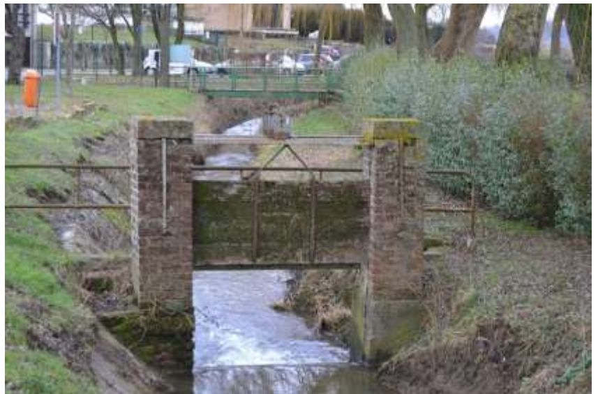
Très ancien ouvrage de retenue réglable sur le Coeurcq Un ouvrage peu coûteux de ce type permettrait de bloquer et de dévier totalement l'eau du Hain dans la ZIT du « PARADIS »
